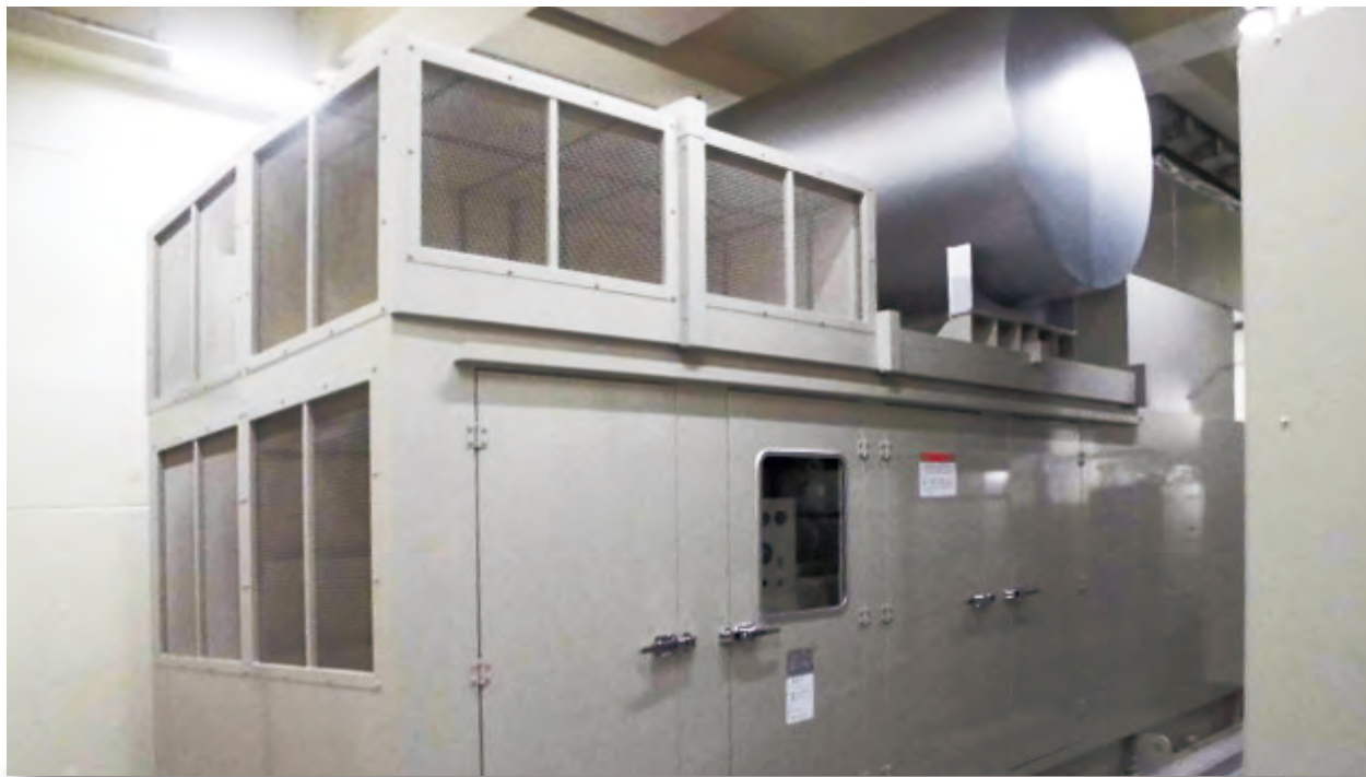
▲ 発電機室内非常用発電機設置
