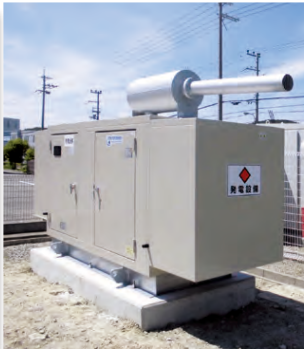
▲ 非常用発電機設置(コンクリート基礎含む)
