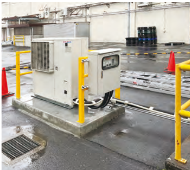
▲ 冷凍機・制御盤
