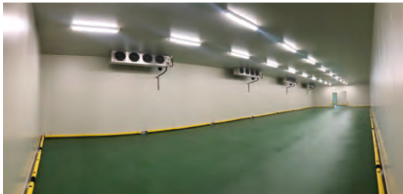
▲ 冷蔵面積200坪、庫内高さ3.8mの冷蔵設備
