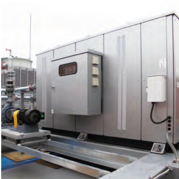
▲ ガス吸収式冷温水機更新(屋上設置)
