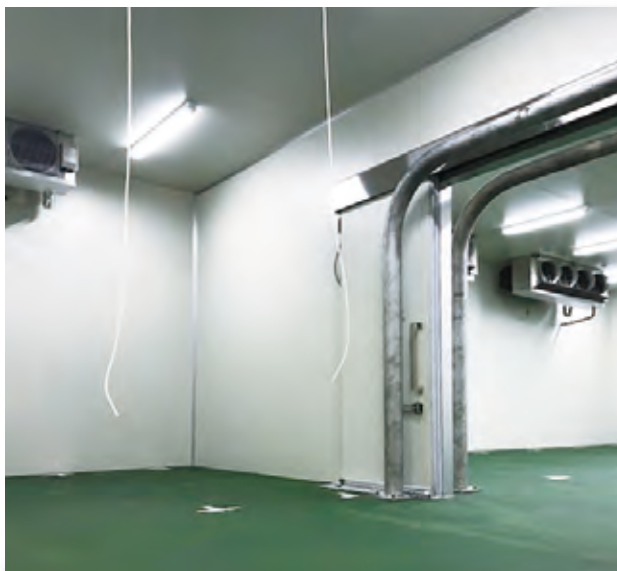
▲ 冷凍・冷蔵庫内断熱パネル施工
