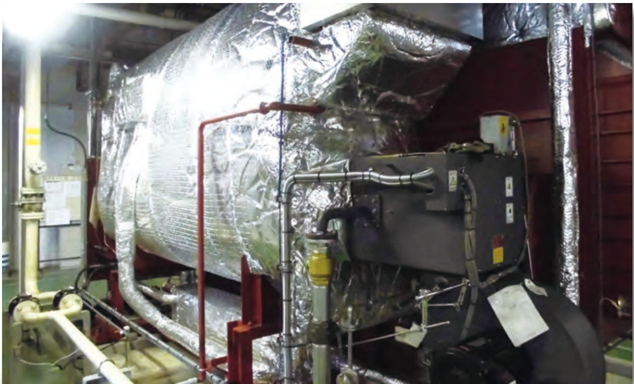
▲ ガス吸収式冷温水機更新(屋内設置)
