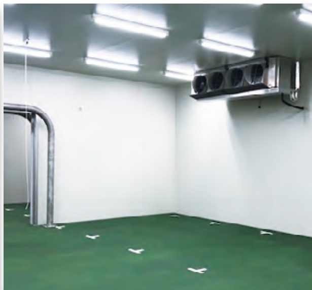
▲ ユニットクーラー施工と低温用LED照明施工
