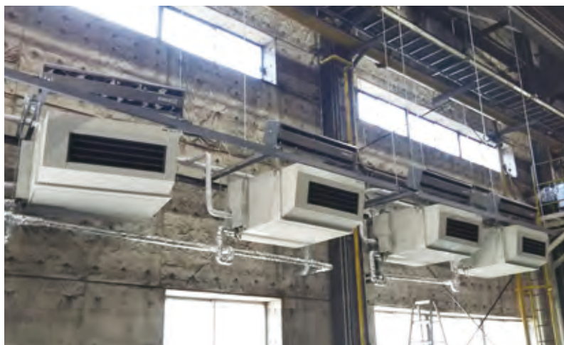
▲エアー搬送ファン+設備用パッケージエアコン室内機設置
