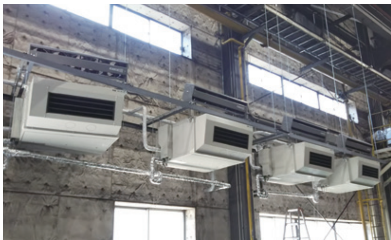
▲エアークーリングファン+設備用パッケージエアコン室内機設置
