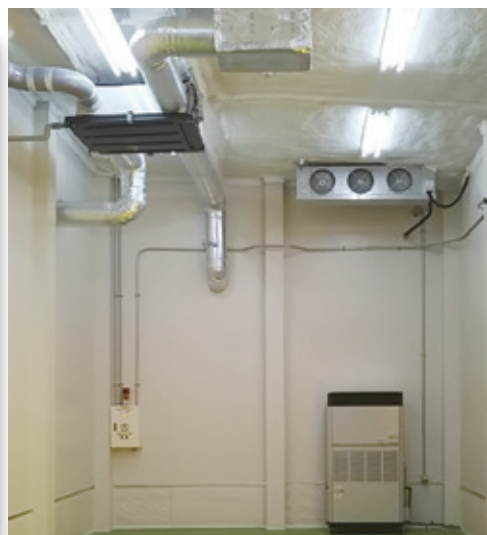
▲ 床置形除湿機施工
