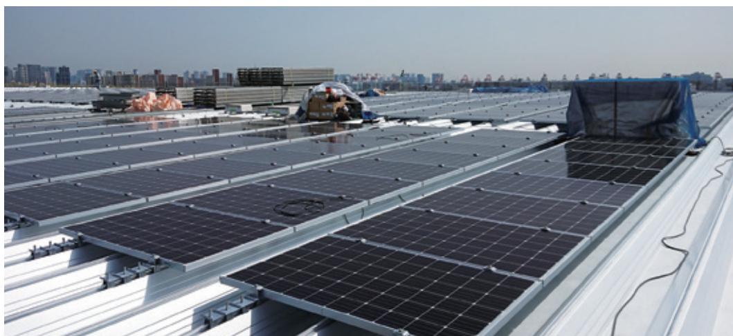
▲ 屋上モジュール施工
