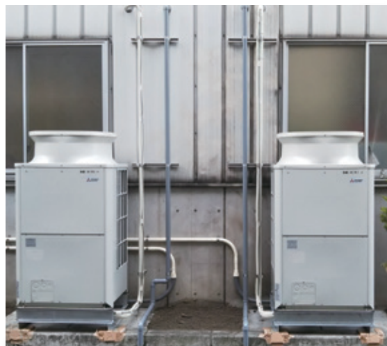
▲設備用パッケージエアコン室外機設置
