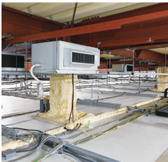
▲ 天吊形除湿機施工
