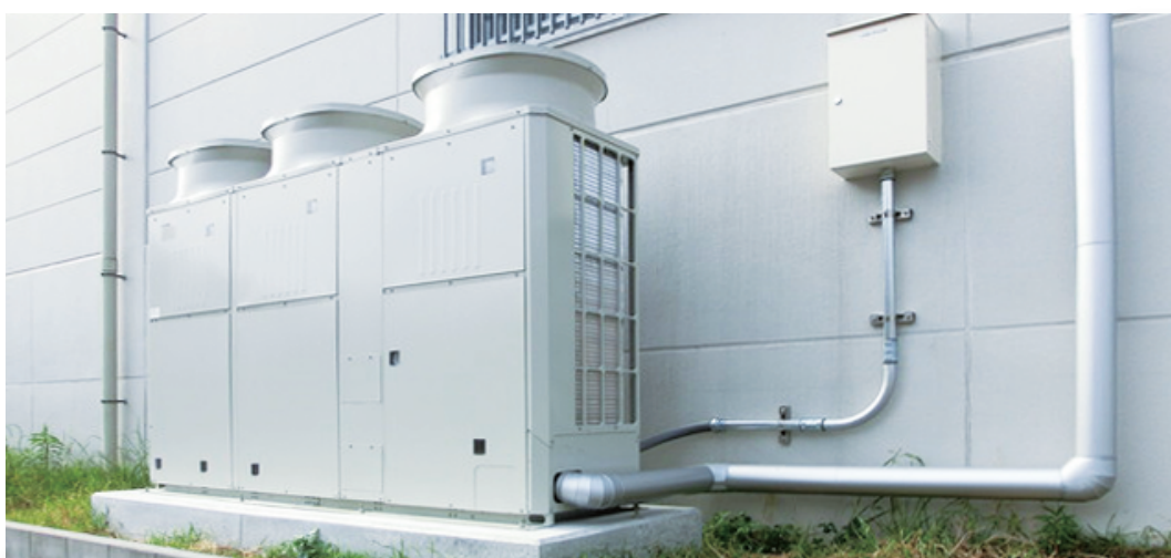
▲ コンデンシングユニット施工
