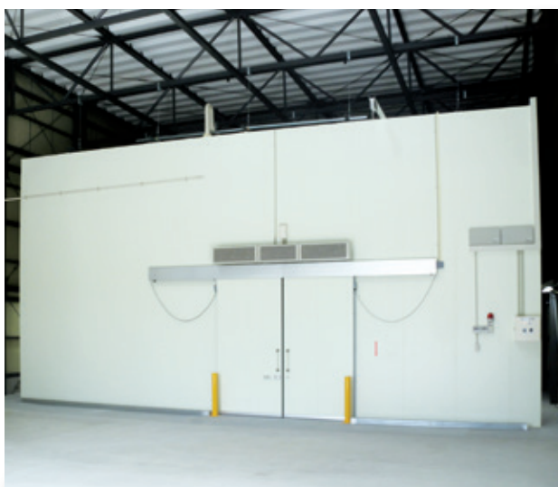
▲ プレハブ冷凍・冷蔵庫施工
