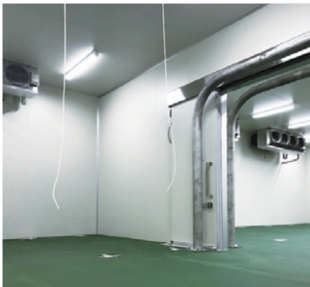
▲ 冷凍・冷蔵庫内断熱パネル施工
