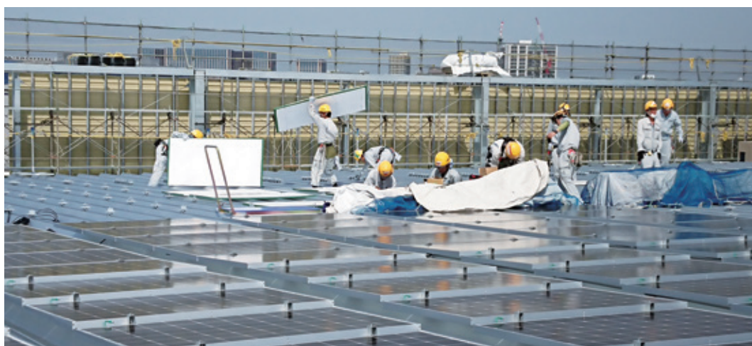
▲ 屋上モジュール施工
