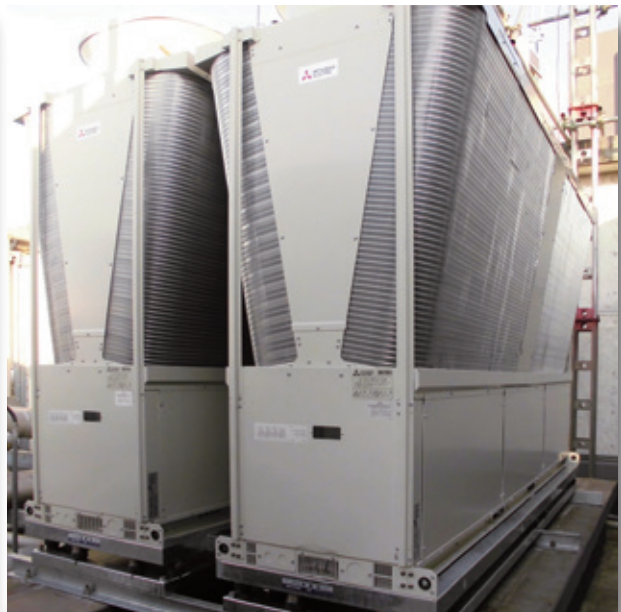
▲ 電気式冷水専用チラー更新(屋上設置)
