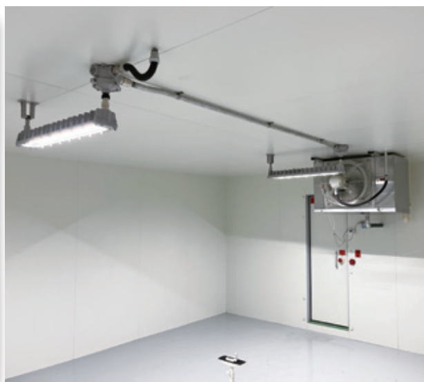
▲ 断熱パネル施工
