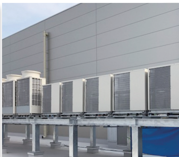
▲ コンデンシングユニット施工
