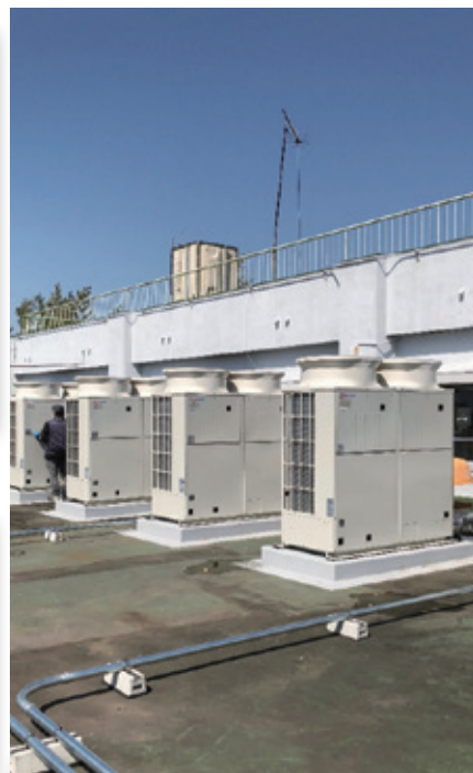
▲ コンデンシングユニット施工
