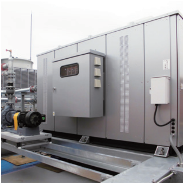
▲ ガス吸収式冷温水機更新(屋上設置)
