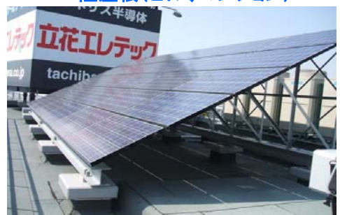
陸屋根(ビル、マンション)
