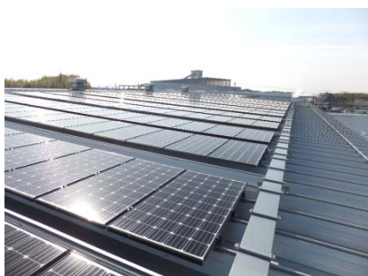
折板屋根(工場)
